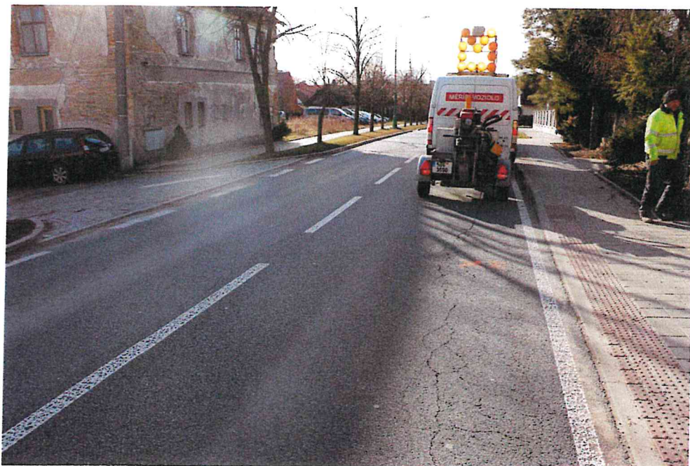
Obr.9: Mozaikové (síťové) trhliny (stav k únoru 2020)
