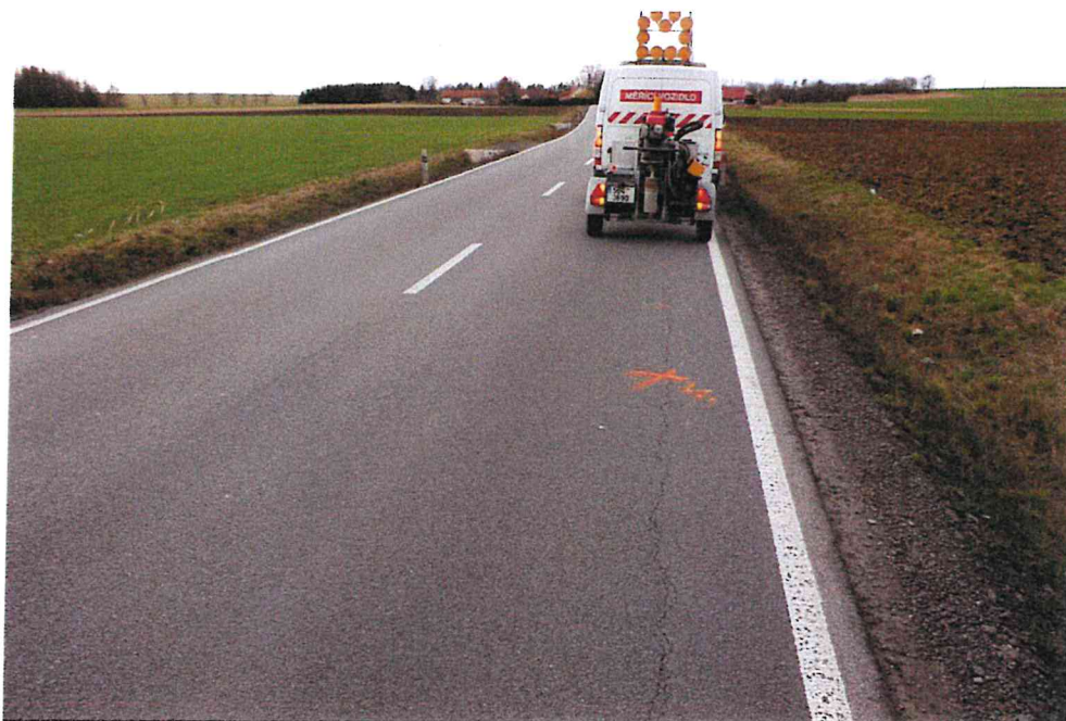
Obr.7: Podélná trhlina (stav k únoru 2020)
