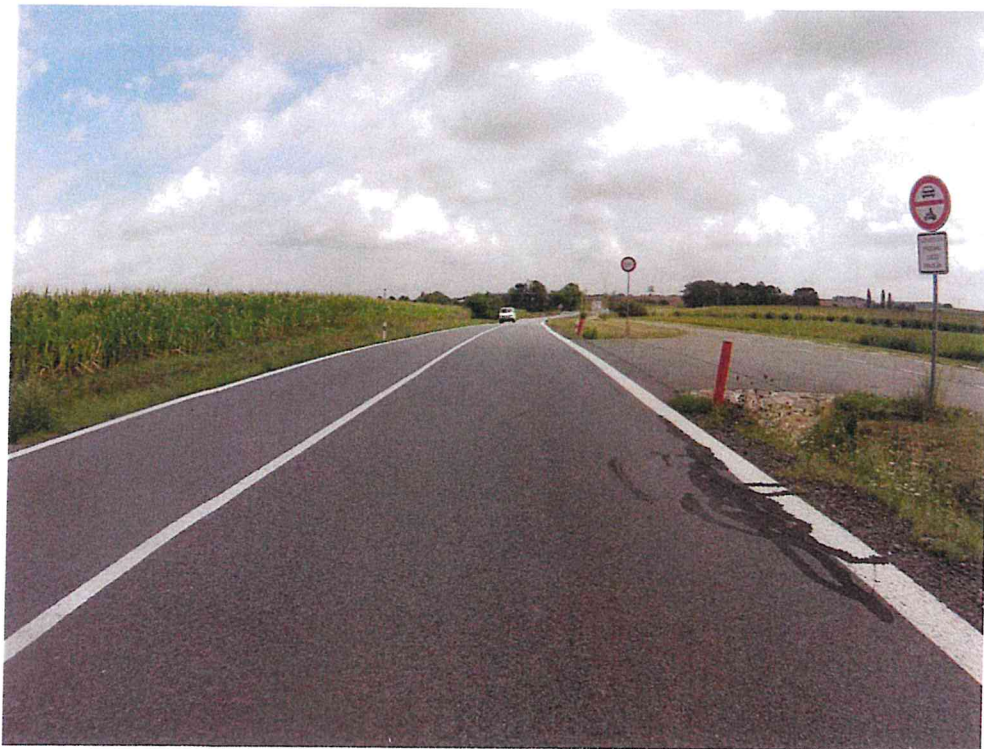
Obr.1: Podélné rozvětvené trhliny (stav k srpnu 2019)
