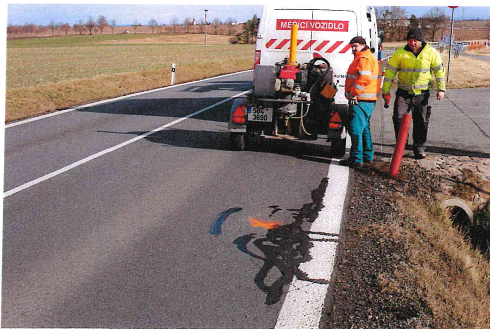
Obr.2: Podélné rozvětvené trhliny (stav k únoru 2020)
