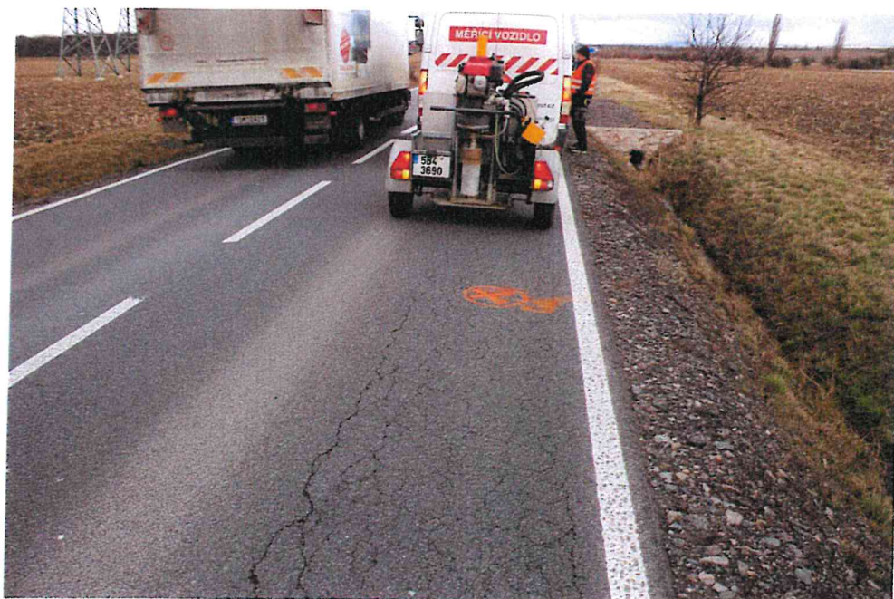
Obr.6: Mozaikové (síťové) trhliny (stav k únoru 2020)
