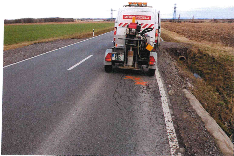
Obr.4: Mozaikové trhliny (stav k únoru 2020)
